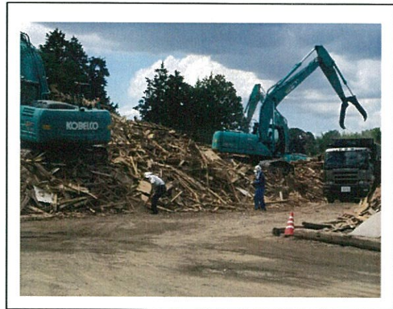
被災した材木・木材の受け入れ
